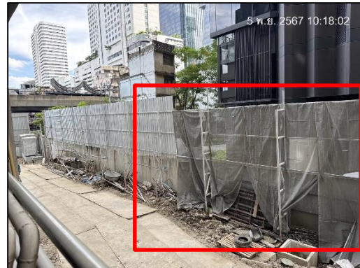
ภาพที่ 8 ผ้าใบ Mesh Sheet
