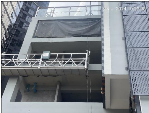
ภาพที่ 8 ผ้าใบ Mesh Sheet
